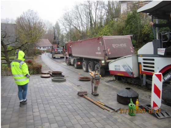
(Regel Arbeitsbetrieb beim Asphaltieren der Straße „Im Siepen“)
