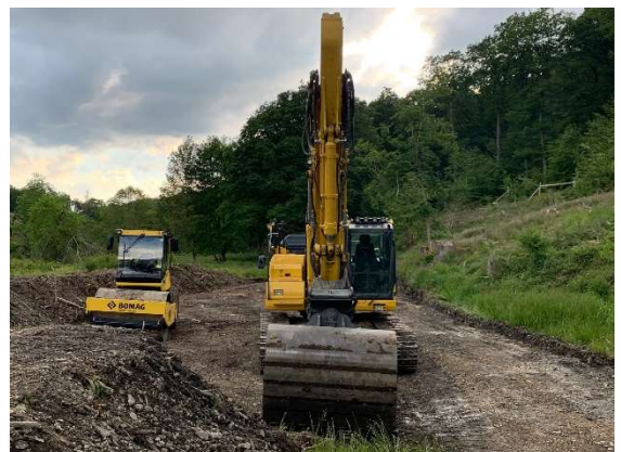
(Baubeginn der Erdarbeiten erfolgte Ende Mai 2022)
